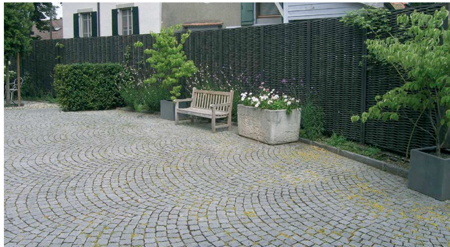
La clôture qui permet d'isoler cette cour de son voisinage a été confectionnée en fibre synthétique tressée qui laisse filtrer l'air. Réalisation paysagère de Jacquet SA, www.jacquet.ch
