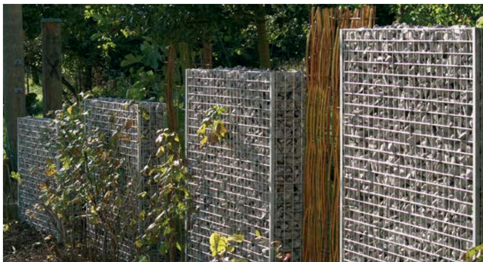
Pour garantir la stabilité de l'édifice, la hauteur d'un gabion ne doit pas dépasser plus de trois fois son épaisseur. Ici, les gabions à cornières sont posés sur des socles en béton. Ils alternent avec des cloisons légères en saule tressé. Structures réalisées par Cribri Sàrl, www.cribri.ch
